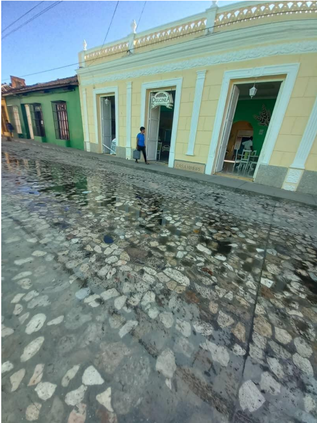
Figura 6 Salidero de agua significativo en la Calle Gutiérrez
