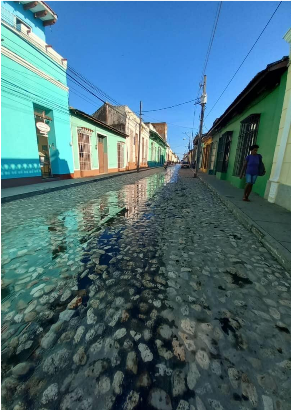
Figura 2 Calle del centro histórico que muestra salideros de agua
