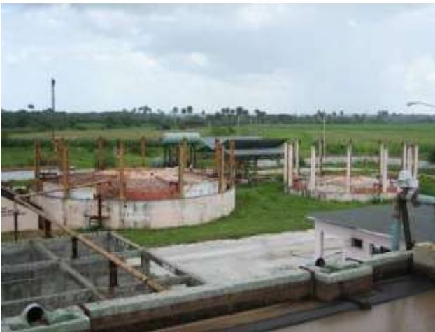
Figura 6- Digestor UASB construido de hormigón
