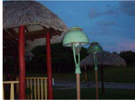
Biogás para iluminación
