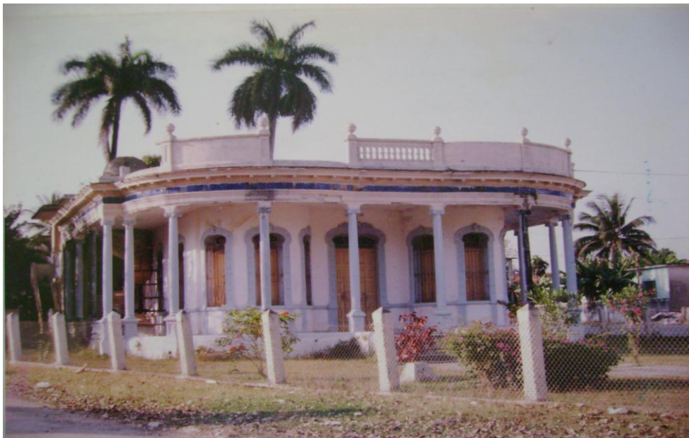
Fig. 6. Chalet de Fortún ya avanzada la época de la Revolución. Se evidencian el deterioro y el abandono que son hoy aun más críticos.
