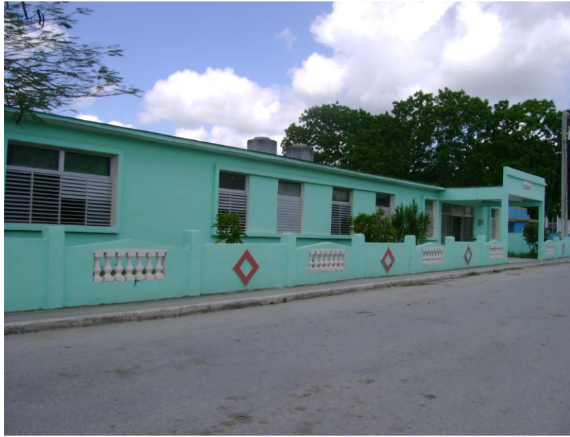
Fig. 3. Sala de Rehabilitación Física.
