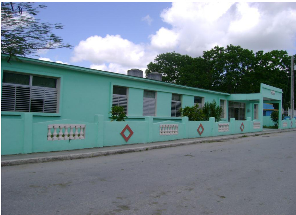
Fig. 2. Sala de Rehabilitación Física.
