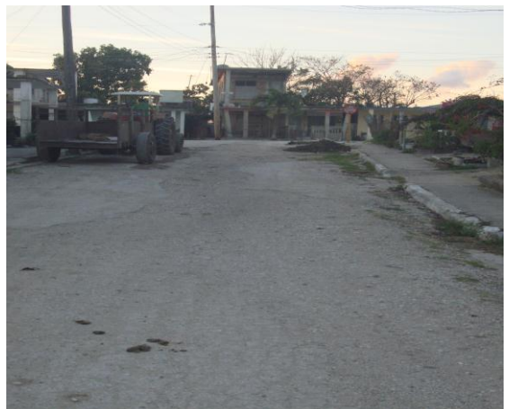
Fig.84-d) Deterioro en la pavimentación
