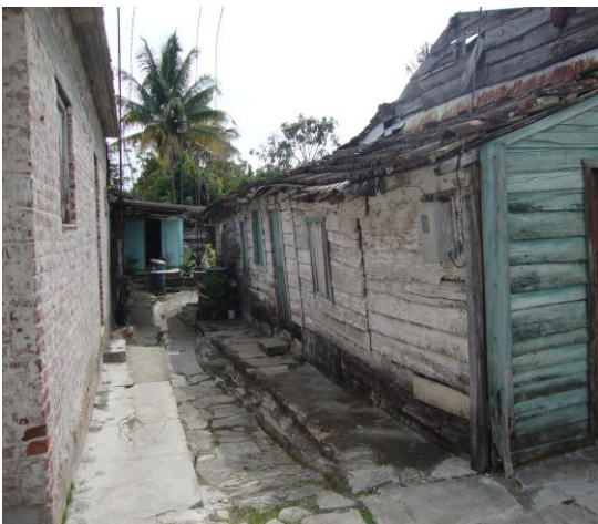
Fig.102- Cuartería en la calle Isidro González.
