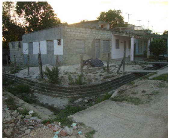
Fig.86-d) Zanjas en derrumbe.
