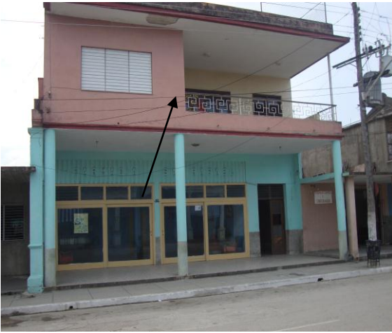
Fig.51- Casa de Osvaldo Ríos
