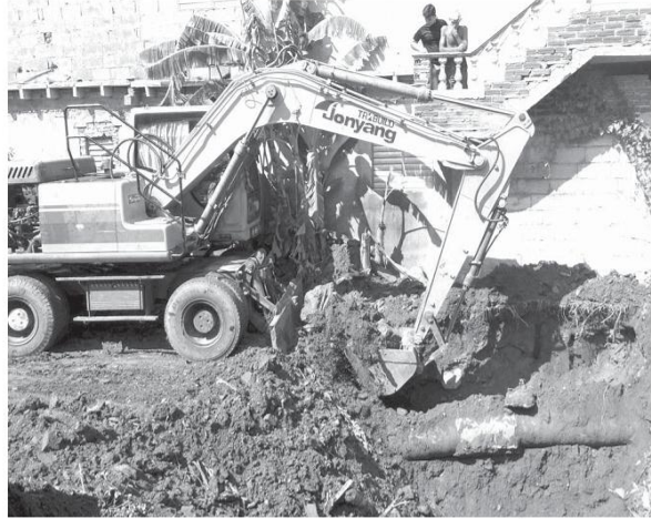
Fuerzas del territorio acometen la reparación de la conductora que abastece a Colón. /Foto: Reidel Gallo
