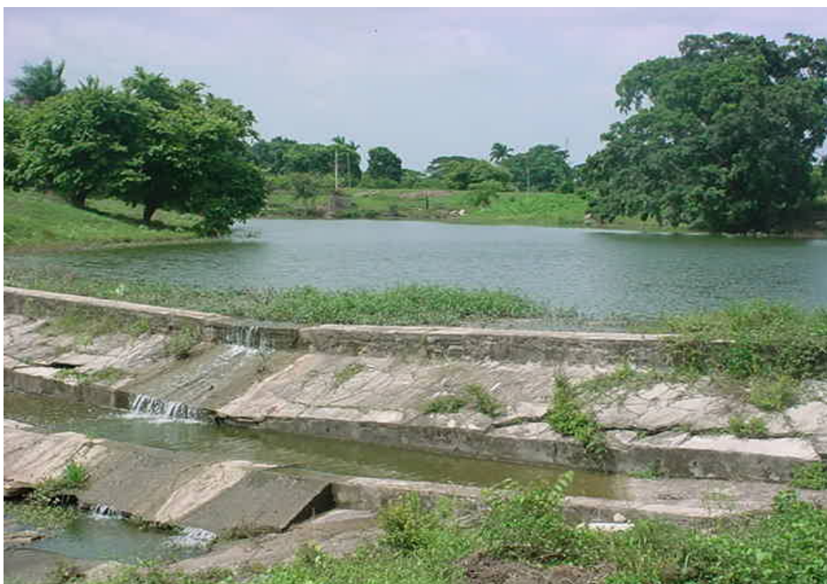
Imagen # 1 Muestra un Micro embalse construido en la década de 1960, respondió a la idea estatal de crear fuentes de agua para el regadío, cuentan los vecinos del lugar que cuando se construyó tenía entre 5 y 7 metros de profundidad, actualmente se encuentra rellena con la tierra arrastrada por las aguas y no tiene más de un metro de profundidad.
