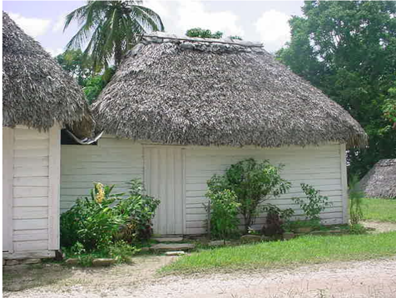
Imagen # 27 Lateral de la casa de vivienda tradicional, prácticamente desaparecida.
