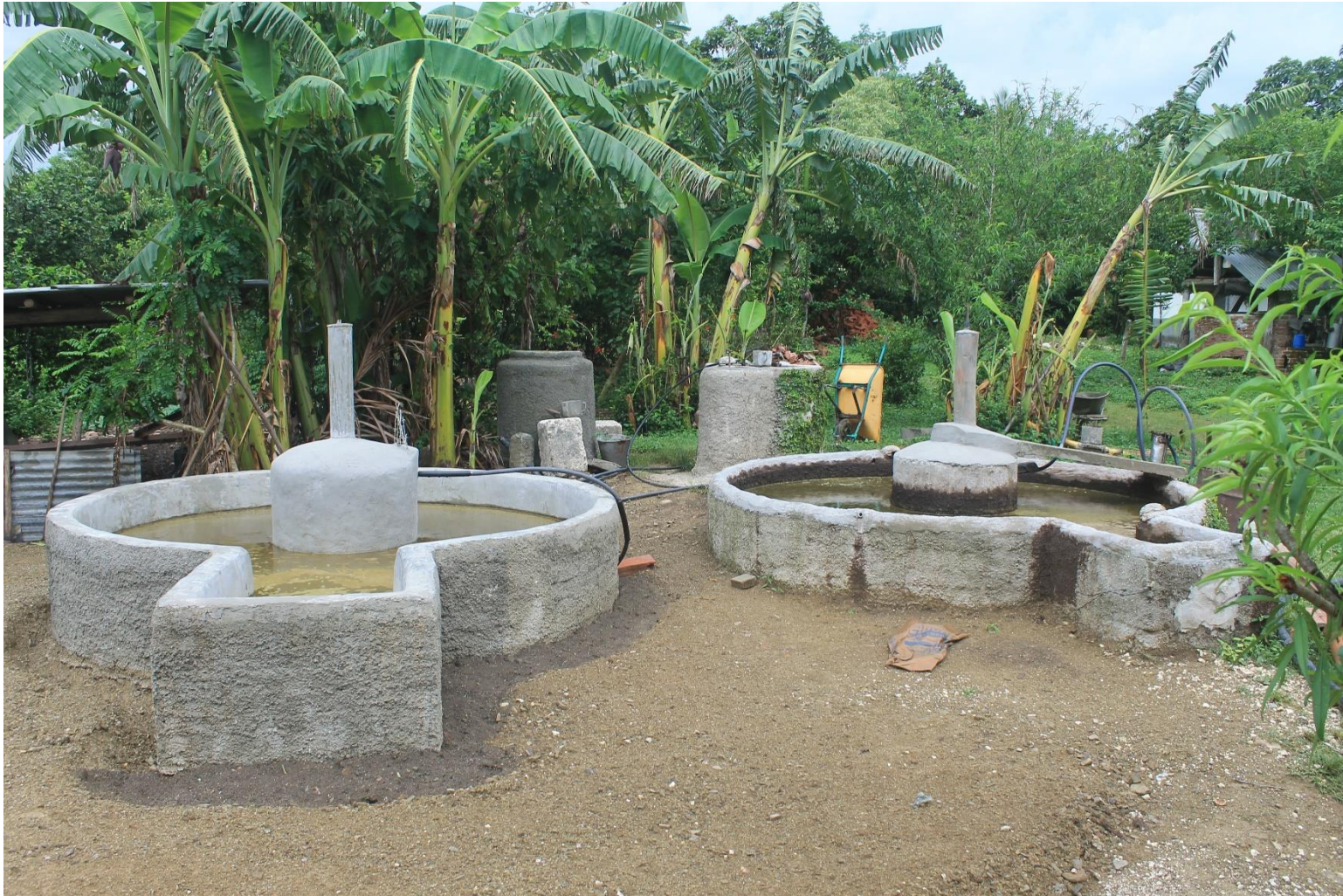
Anexo 11. Biodigestores en serie para la producción de biogás y fertilizantes.
