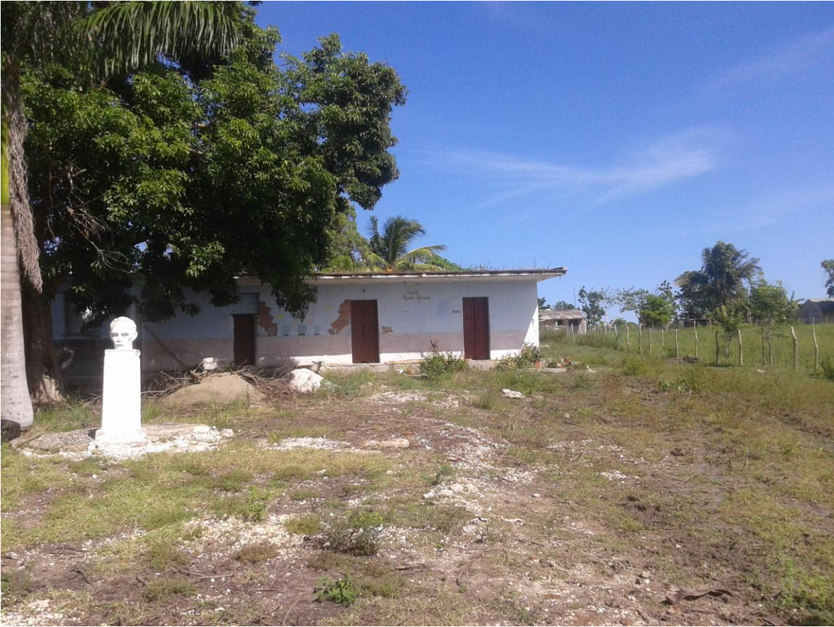
Anexo 15: Escuela primaria “Ramón Ponciano Romano” de la comunidad El Majá, la misma se encuentra en mal estado constructivo.
