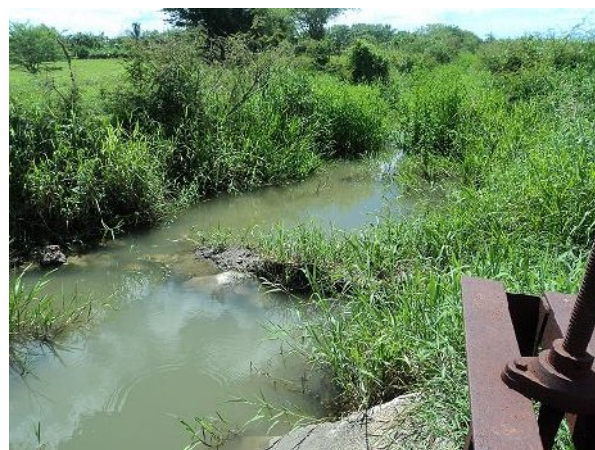
Figura 4 Canal de drenaje C-0-2
