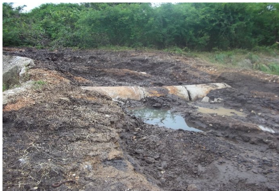
Figura 7. Terraplen El Bayo.
