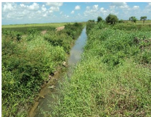
Figura 3. Canal de drenaje I.
