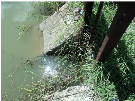
Figura 10. Obra de toma R-2
