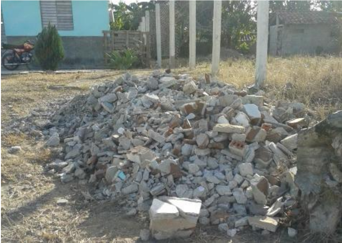
Acumulación de escombros
