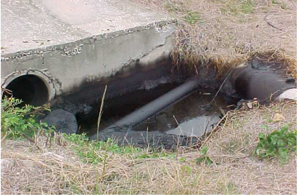
Foto # 15: Derrames del sistema de residuales (salida exterior)
