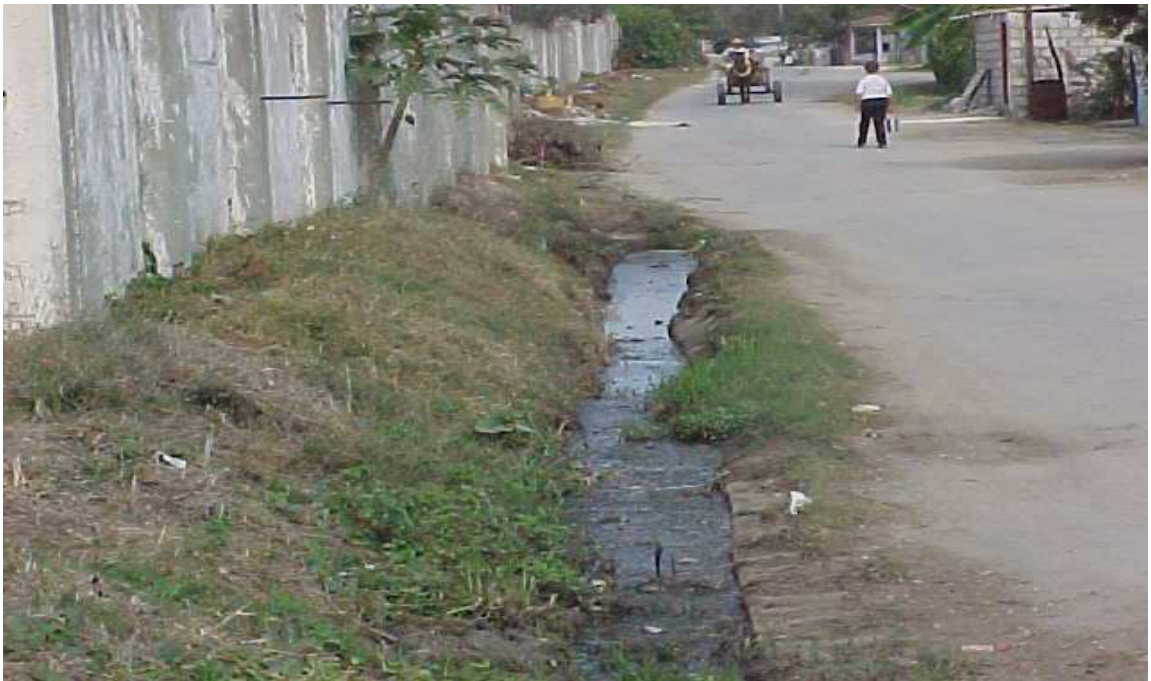
Foto # 12: Área exterior de cercado perimetral de la Empresa
