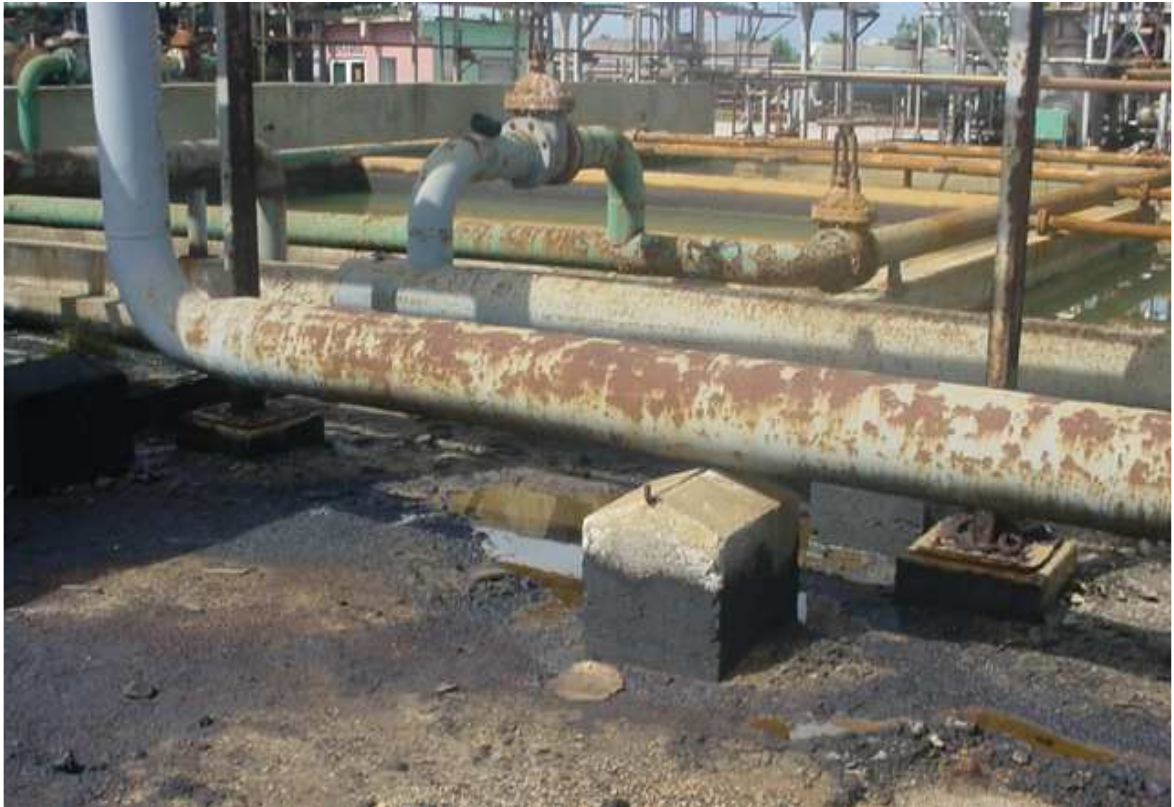
Foto # 9: Sistema de enfriamiento de la Planta de Destilación.
