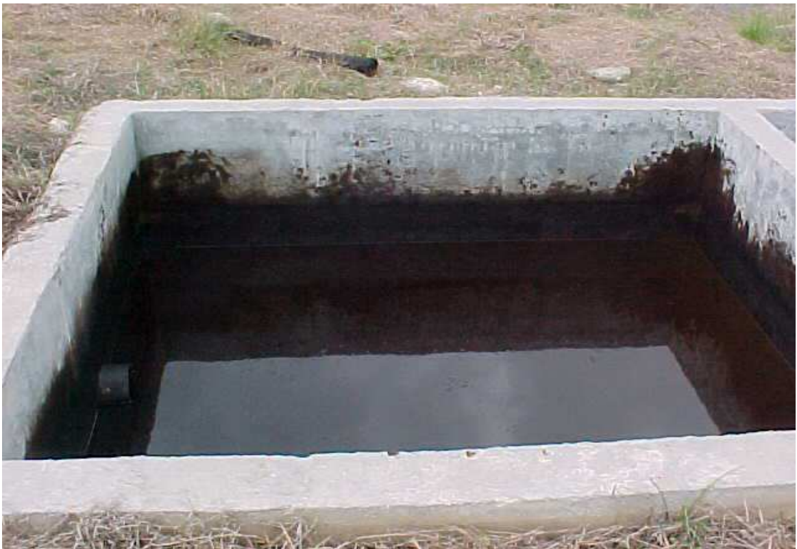
Foto # 14: Filtro de virutas en la trampa # 46.
