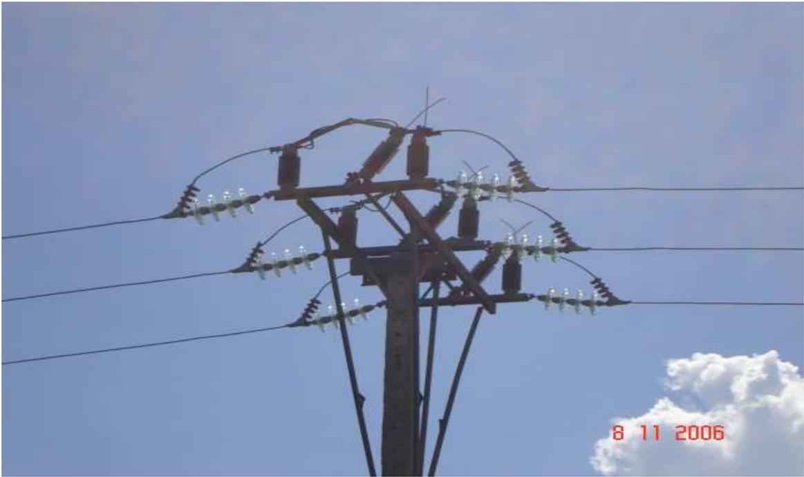
**Foto 2: Tubo para manipular el desconectivo en aire**
