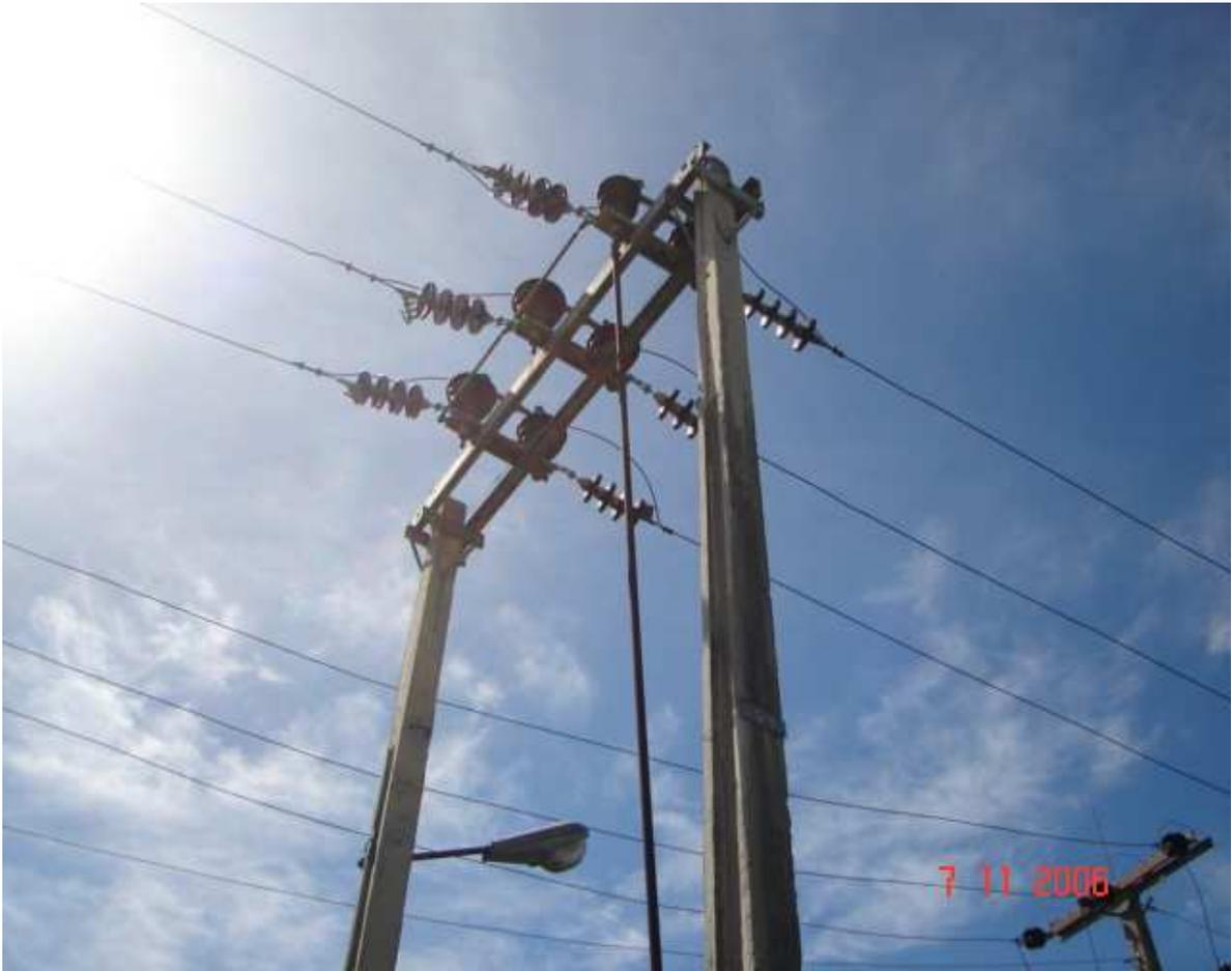
**Foto3: Manipulador del desconectivo en aire**
