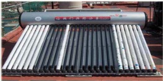
**Fig. 2. Calentador solar de tubos al vacío.**
