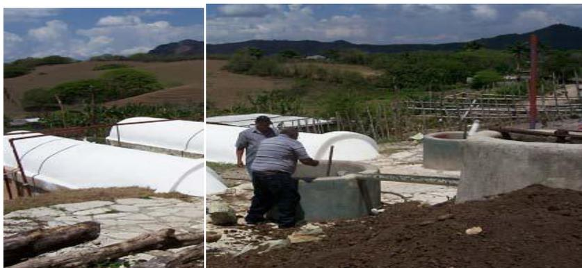
Beneficia a 78 viviendas, 298 habitantes y con una capacidad de 100 m<sup>3</sup> de biogás por día; con una generación de energía eléctrica (GEE) instalado de 25 KVA, generando 16 horas/día. Combustible utilizado: 20 % de diesel y un 80 % de biogás.
